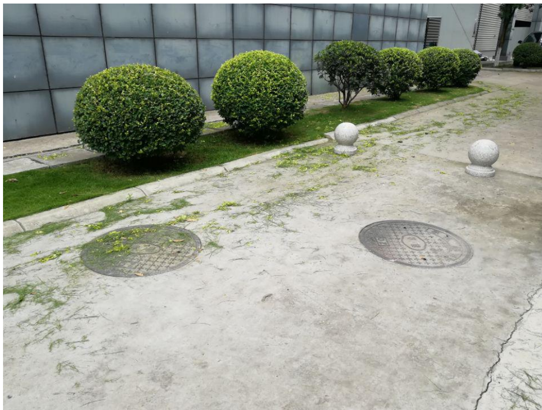
图 3-4 生活污水预处理池出口
