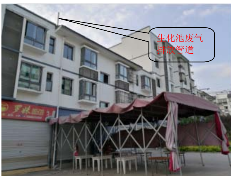
图 4-8 A 区生化池废气排气管道
