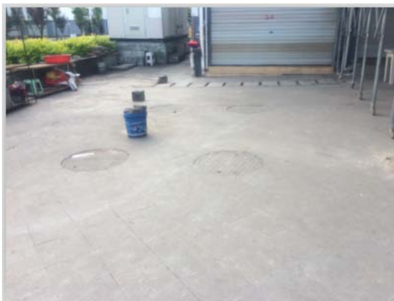
图 4-1 A 区 2#生化池
