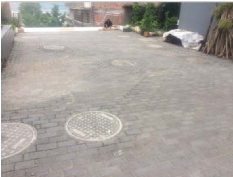
图 4-4 B 区 1#生化池
