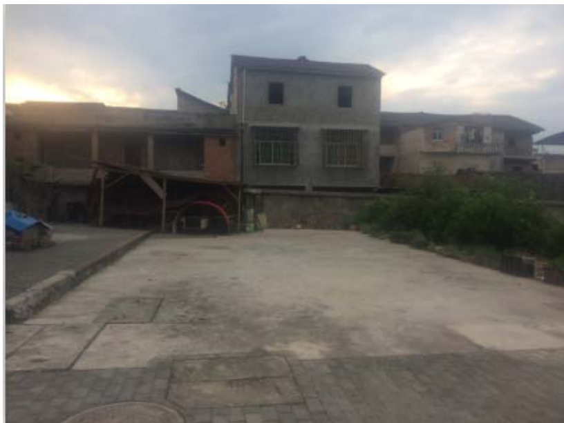
图 4-5 B 区 2#生化池
