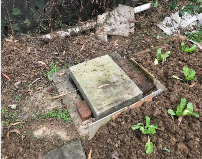
图 3-5 预处理池现场照片
