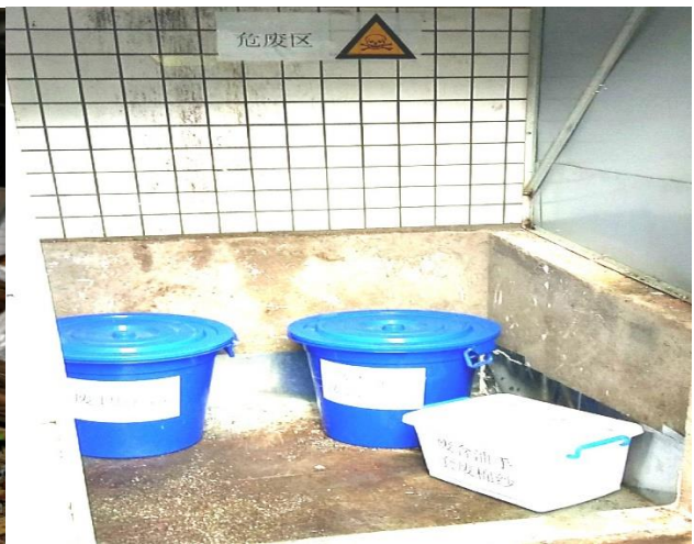
图 3-8 危废暂存间现场内部照片
