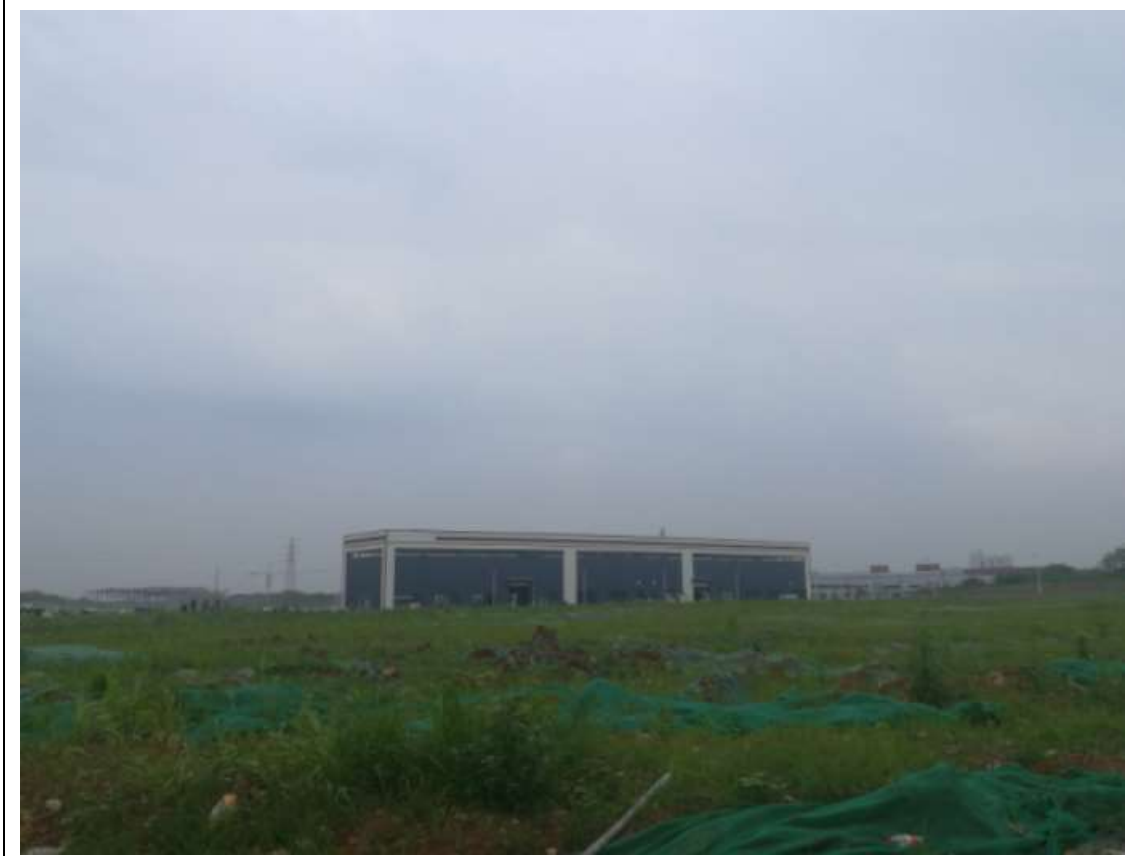
预留的二期地块现状
