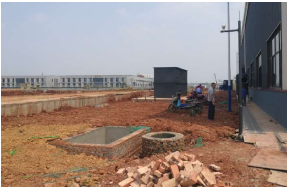
永临结合沉沙池
