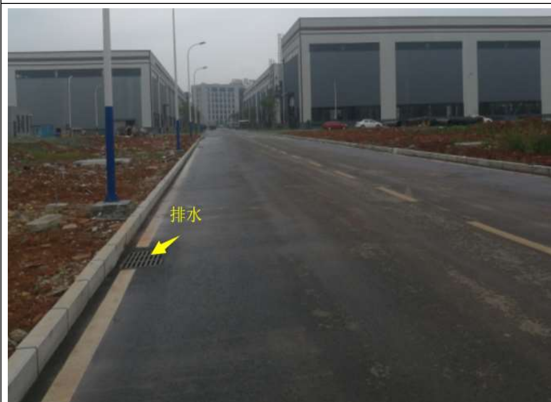
连接整備厂房的道路
