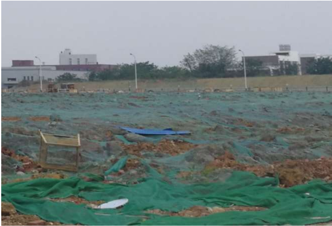
裸露地表覆盖
