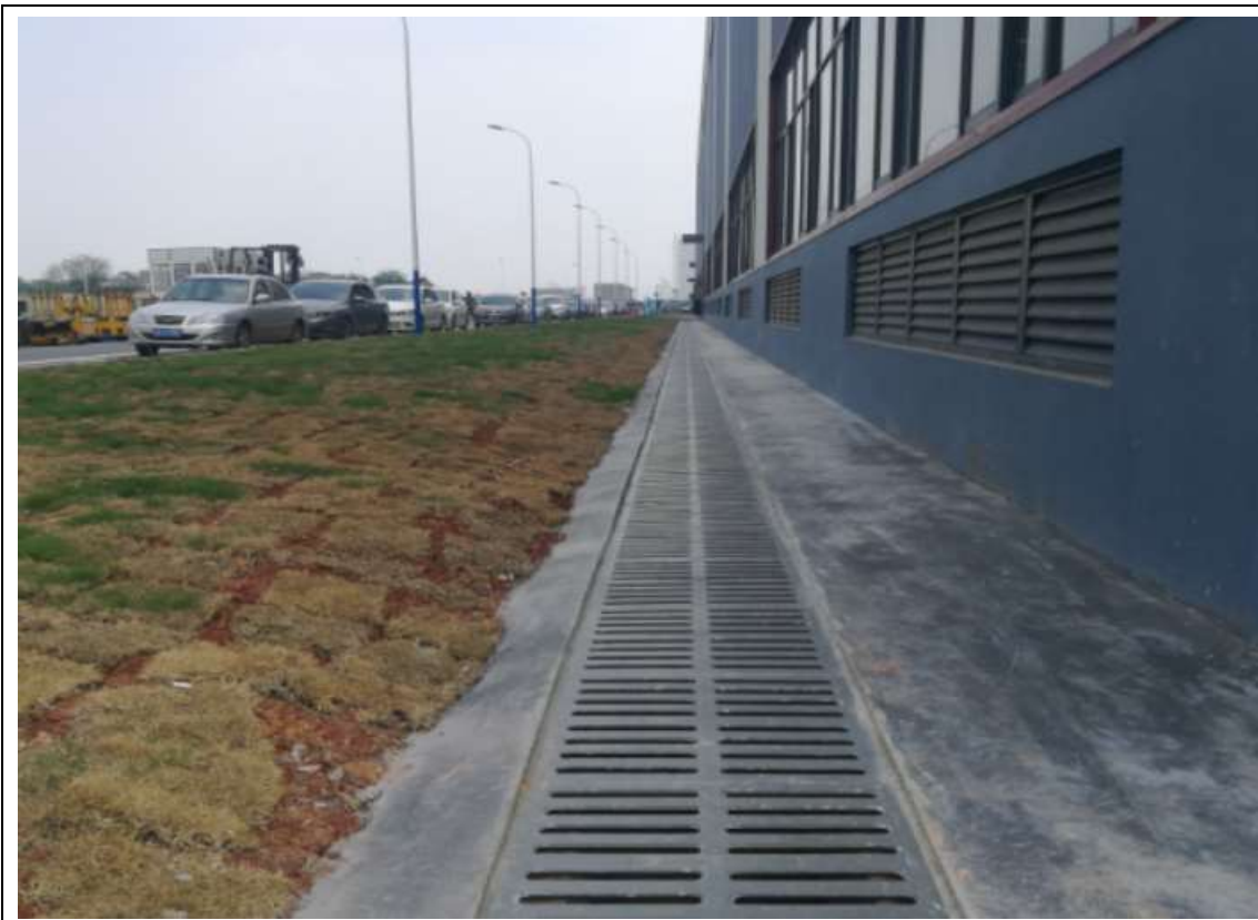
建筑周边排水沟
