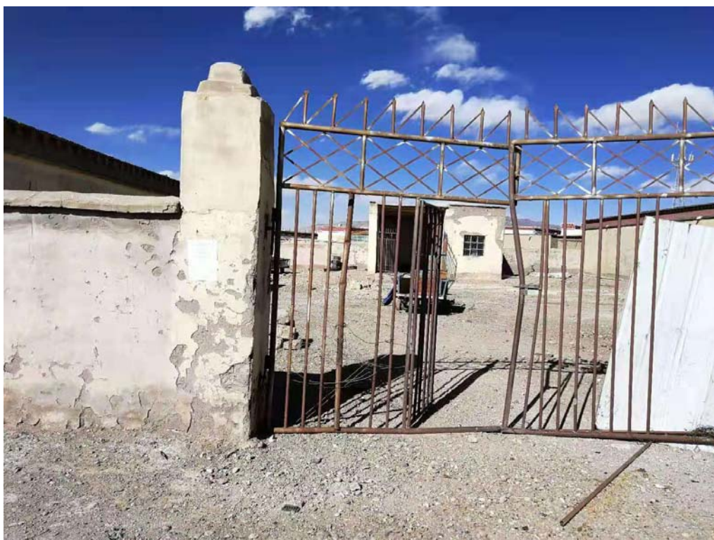
项目现场公告
