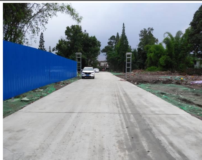
进场施工便道
