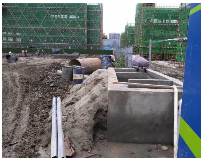
东南角沉砂池
