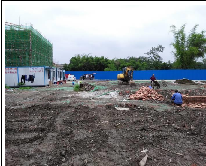
项目南侧施工生产生活区（正在搭建）
