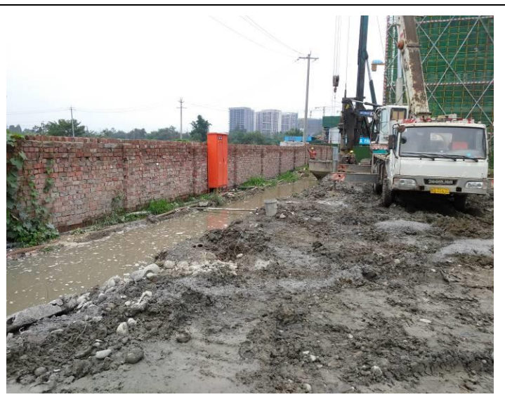
基坑护壁工程打桩（目前建设中）
