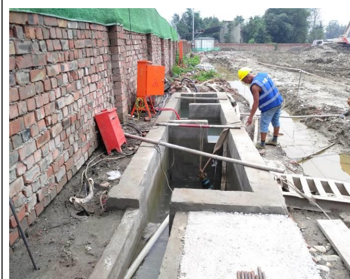
东南角沉砂池
