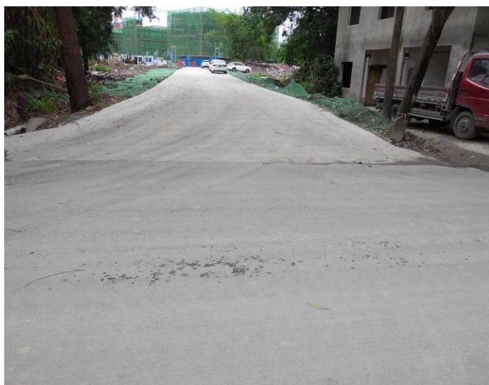
项目施工便道与南侧红蔡路相接
