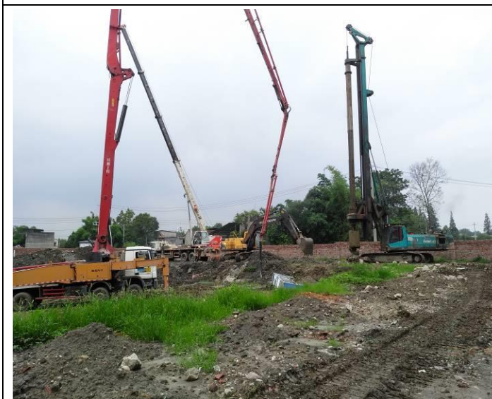
基坑护壁工程（目前建设中）
