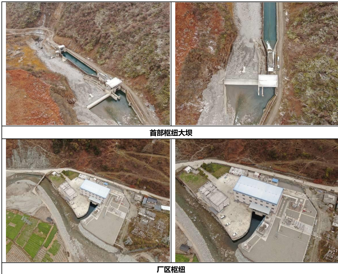
图1-1 主体工程现状
